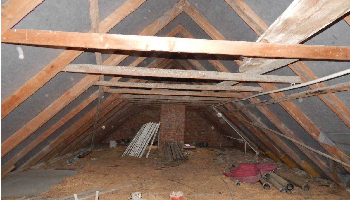
Zdjęcie nr 3 – poddasze – konstrukcja dachu
