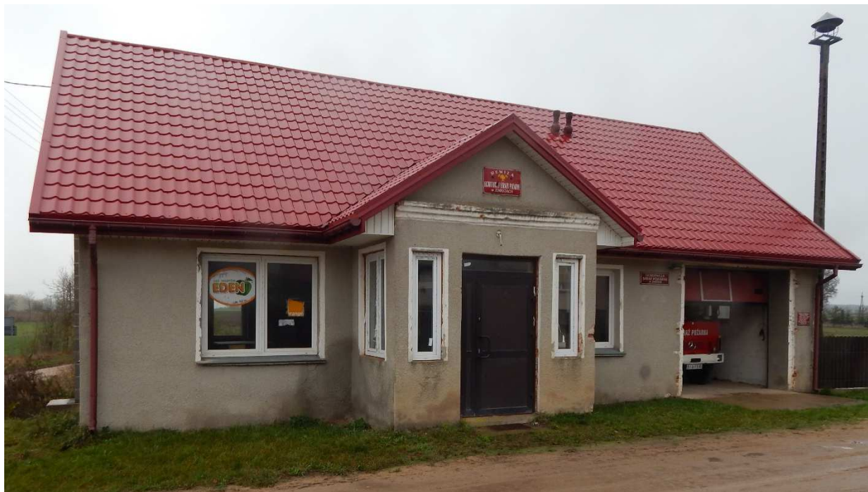
Zdjęcie nr 1 – elewacja frontowa budynku
