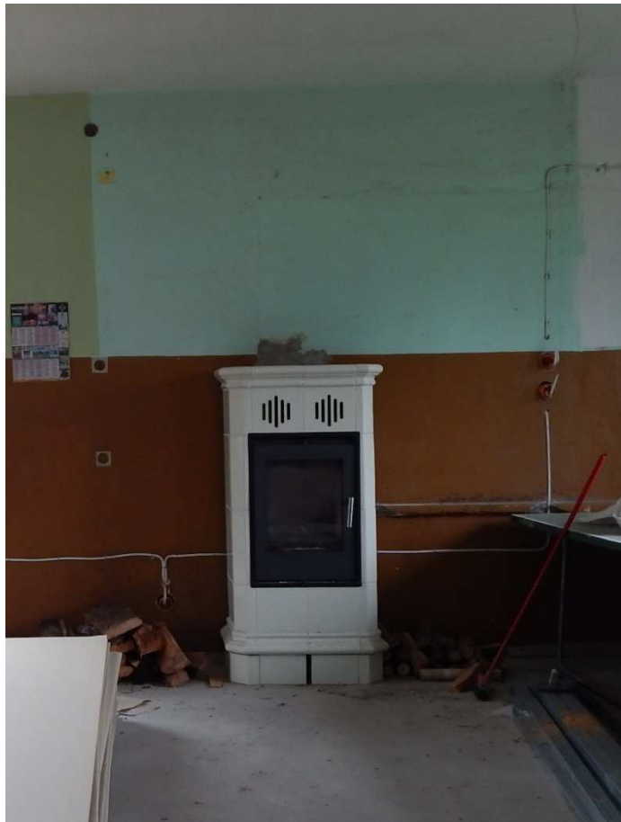
Zdjęcie nr 7 – istniejący kominek w budynku
