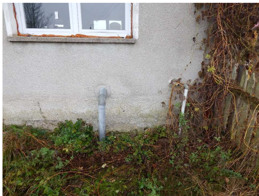
Zdjęcie nr 5 – odprowadzenie kanalizacyjne budynku
