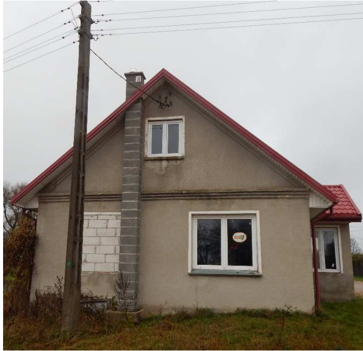
Zdjęcie nr 4 – komin dymowy, zasilenie budynku w energię elektryczną
