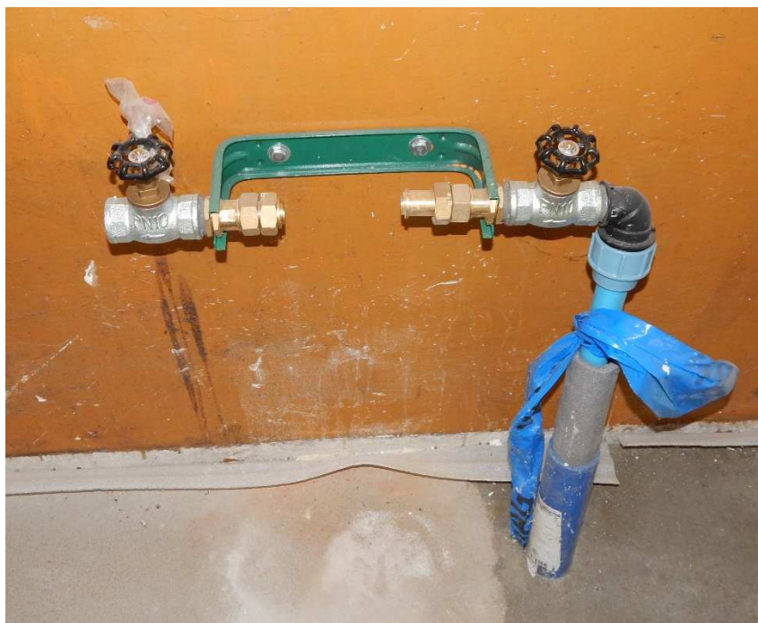
Zdjęcie nr 6 – przyłącze wodne w budynku
