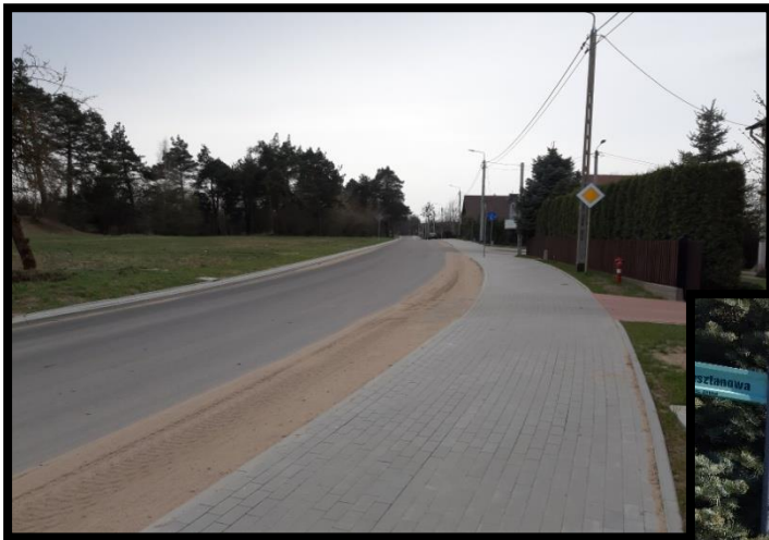
- ciąg pieszo rowerowy w ul. Młynowej - etap I
