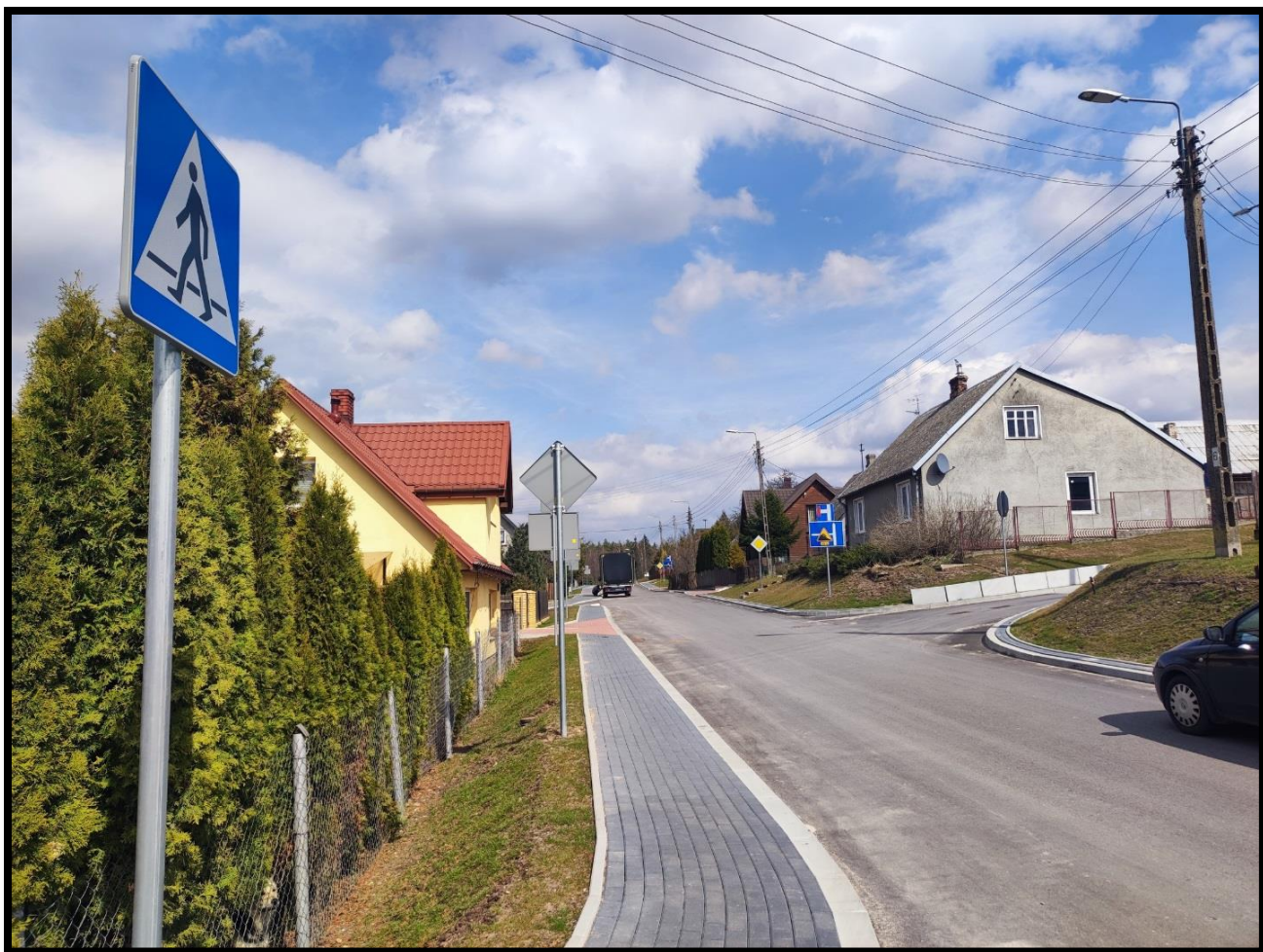
Ad.6 Budowa nawierzchni ulic Leszczynowej i Modrzewiowej wraz z chodnikami, zjazdami i kanalizacją deszczową.
