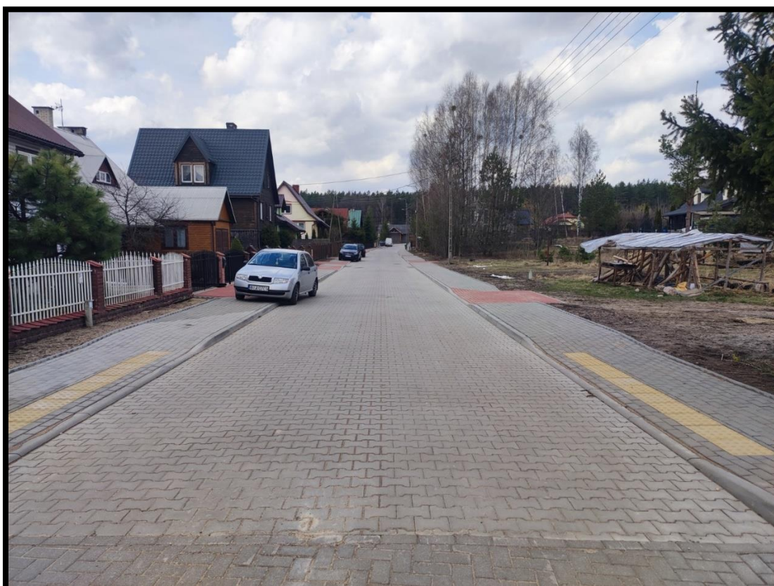
Ad.7 Budowa ulic Myśliwskiej z drogami bocznymi i sięgaczami oraz ulicy Jeżynowej w Czarnej Białostockiej wraz z niezbędną infrastrukturą techniczną oraz rozbiórką studni i budynku garażu o konstrukcji drewnianej” – w ramach zadania: Budowa ulicy Myśliwskiej w Czarnej Białostockiej.
