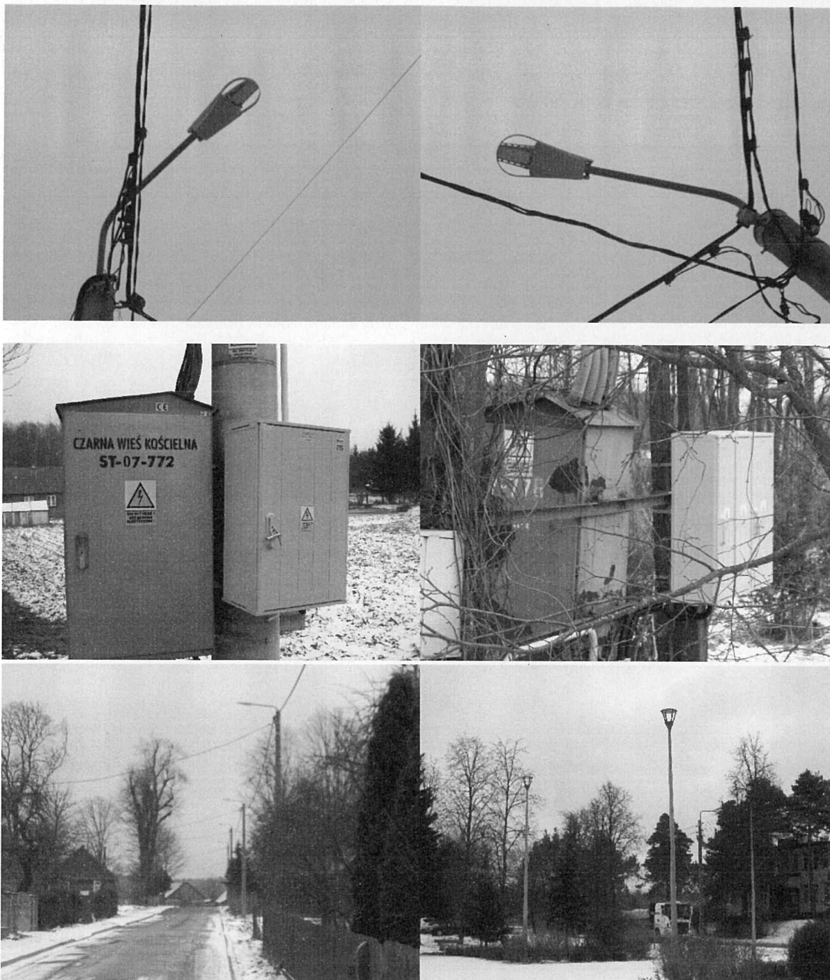
Zdjęcia 1 – 8 Zmodernizowane oświetlenie uliczne na terenie Gminy Czarna Białostocka
