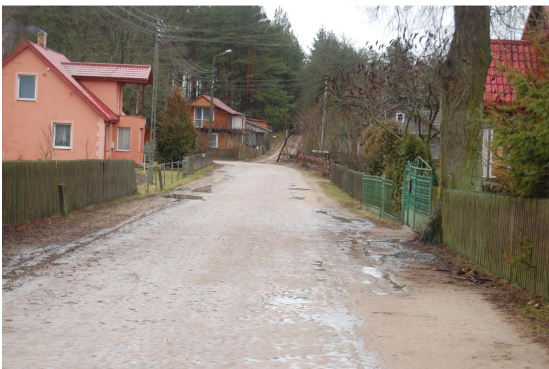
Odcinek w terenie zabudowy m. Łąpczyn
