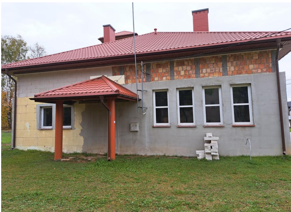
Elewacja południowo - zachodnia
