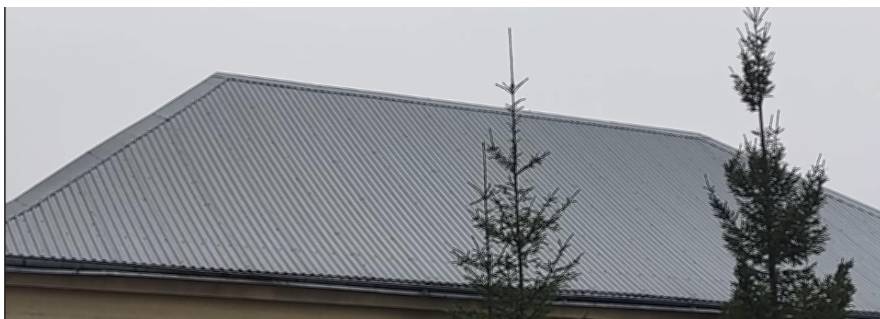
Rys. 2 Widok pokrycia dachu na obiekcie
