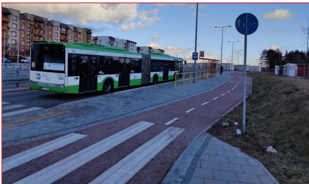
Rysunek 7.5 Przykład nowoczesnej i dobrze utrzymanej infrastruktury pieszej i rowerowej w okolicy przystanku PTZ
