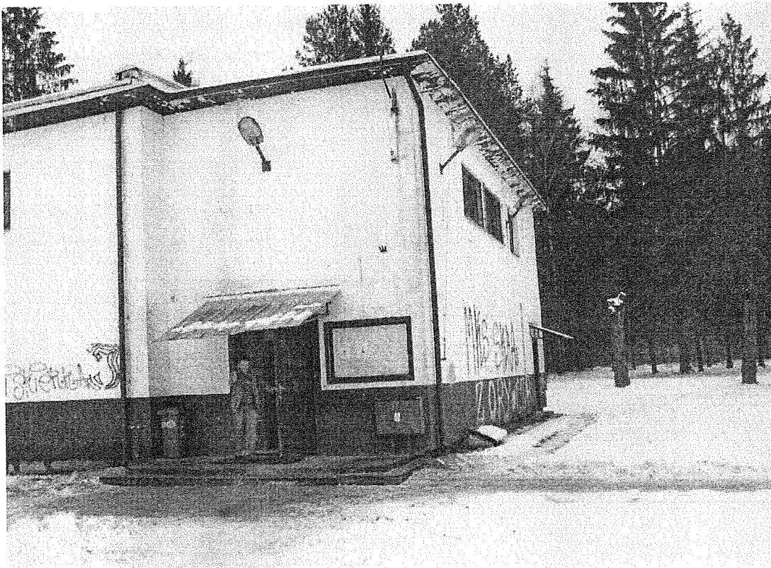
Część socjalna hali dwukondygnacyjna, podpiwniczona.
