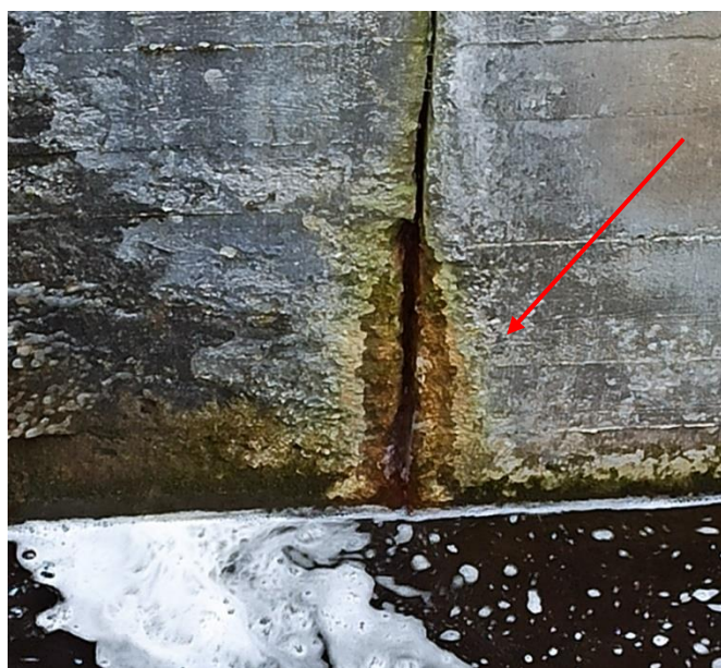
Fot.8 – Ubytek wschodniej ściany jazu od strony wody dolnej wzdłuż dylatacji pionowej; przeciekanie przez konstrukcję
