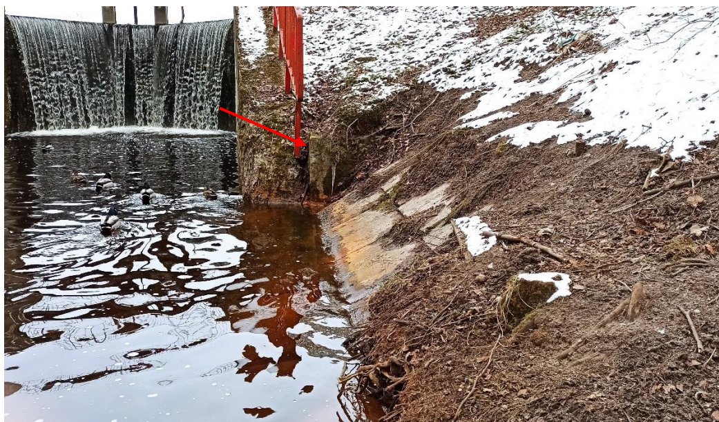
Fot.8 – Ubytek wschodniej ściany jazu od strony wody dolnej wzdłuż dylatacji pionowej; przeciekanie przez konstrukcję
