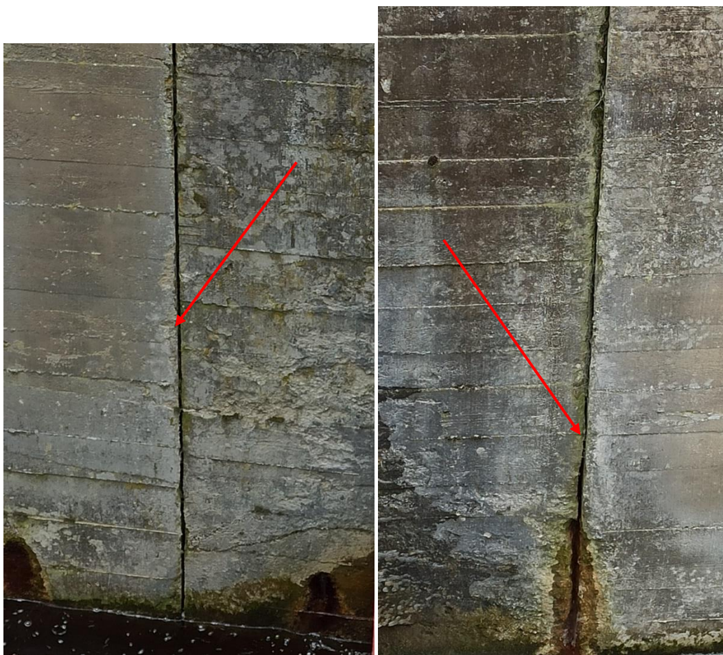
Fot.7, 8 – Zły stan dylatacji pionowych na całej długości
