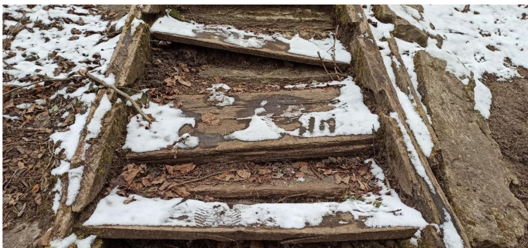
Fot.7, 8 – Zły stan dylatacji pionowych na całej długości
