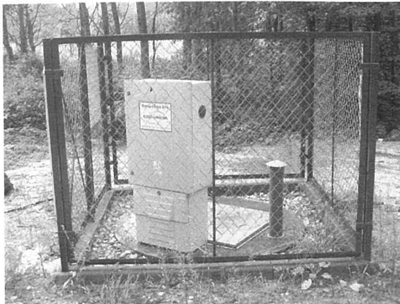
Przepompownię kanalizacji sanitarnej
