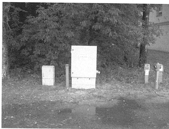
Przepompownie kanalizacji sanitarnej
